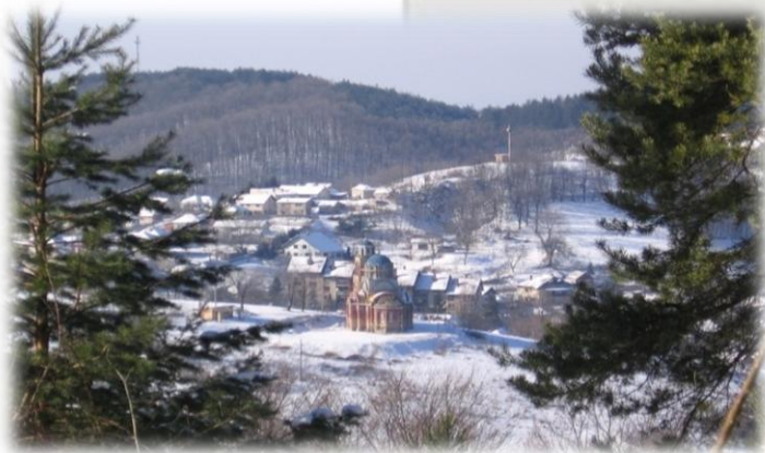
Slika 33 : Crkva na Rudniku
