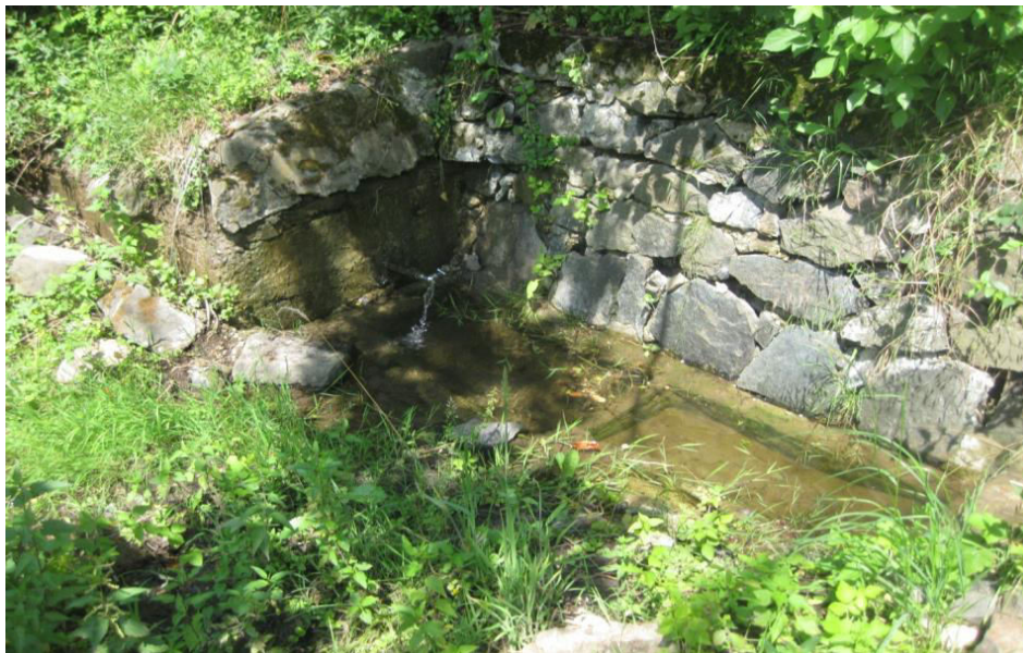
Слика 5. Каптажа „Радојевића извор“
