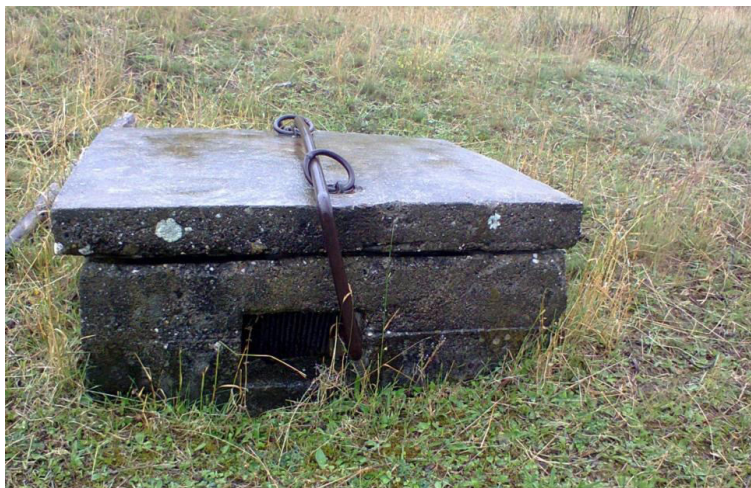
Слика 4. Резервоар „Ђевапово Брдо“
