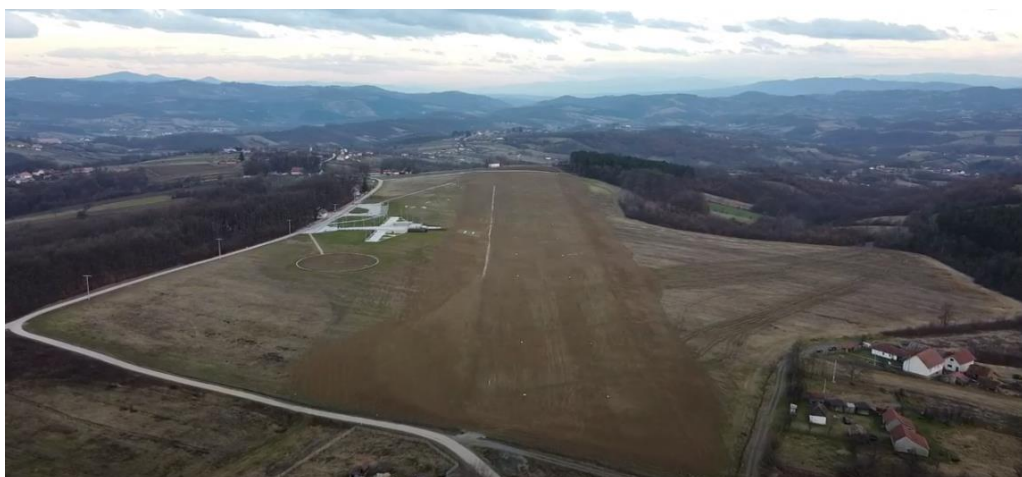
Слика 11. Постојеће стање предметне локације
